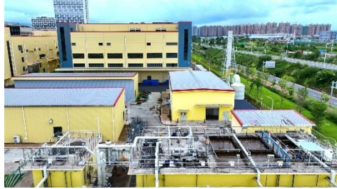
惠州亿纬集能废水处理站
